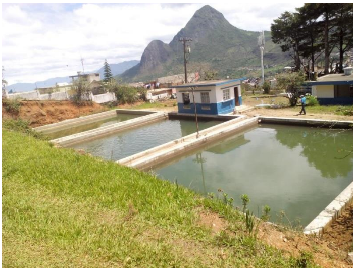
Figura 2-27. Sistema de filtración lenta en arena.
