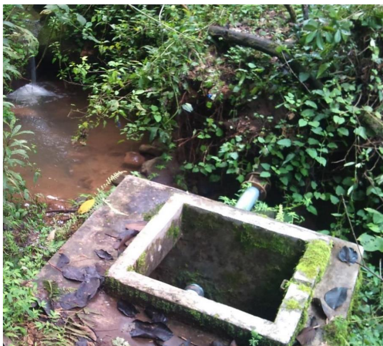
Figura 2-20. Válvula de desagüe (desprotegida)
