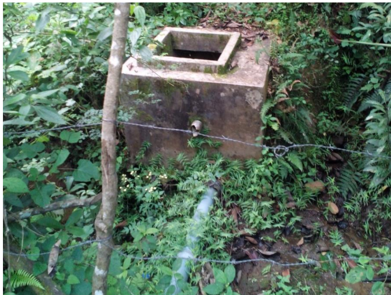
Figura 2-21. Tanque rompe presión (deteriorado)
