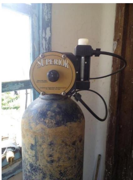
Figura 2-28. Cilindro de cloro gas para desinfección.
