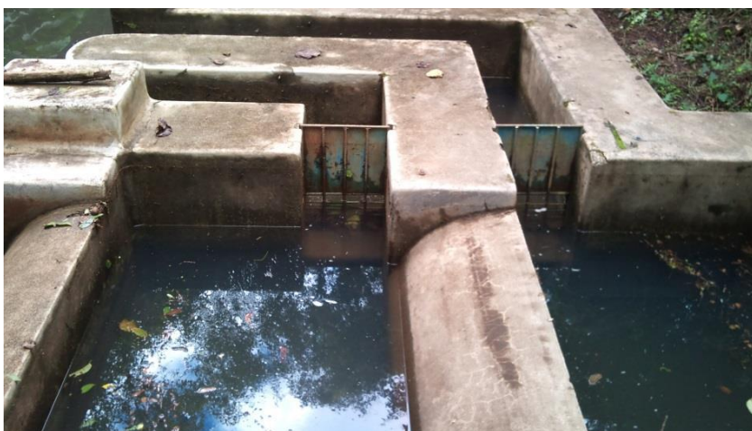
Figura 2-15. Recolección de agua con placas metálicas perforadas.
