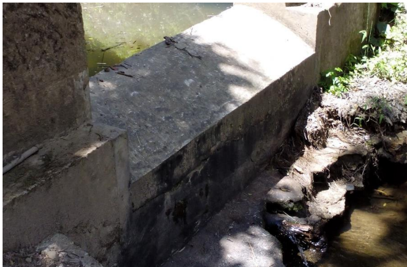
Figura 2-12. Presencia de socavación en el muro transversal.
