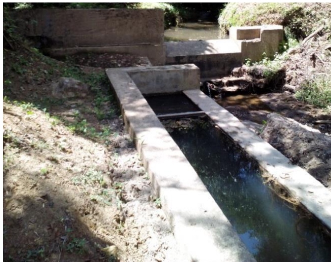
Figura 2-10. Estructura de desarenación.
