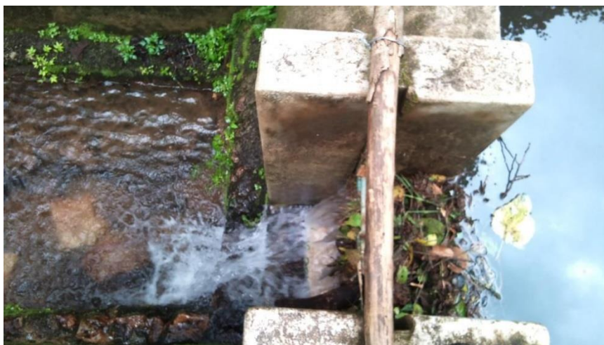
Figura 2-17. Rejilla de salida de excesos.
