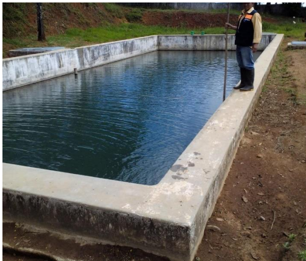
Figura 2-24. Sedimentador de flujo horizontal.
