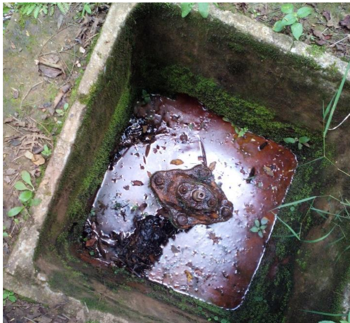
Figura 2-19. Válvula de aire (inundada)
