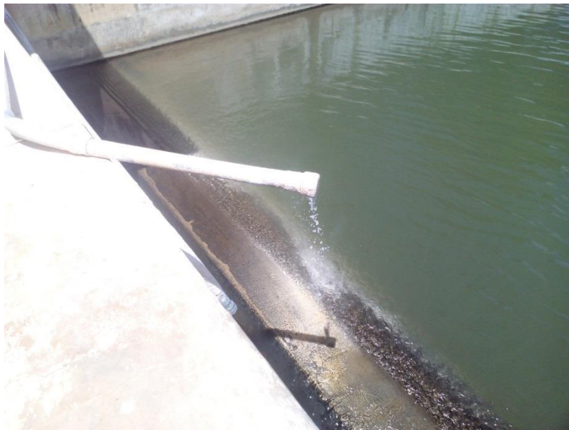
Figura 2-26. Dosificación de sulfato de aluminio y cal.
