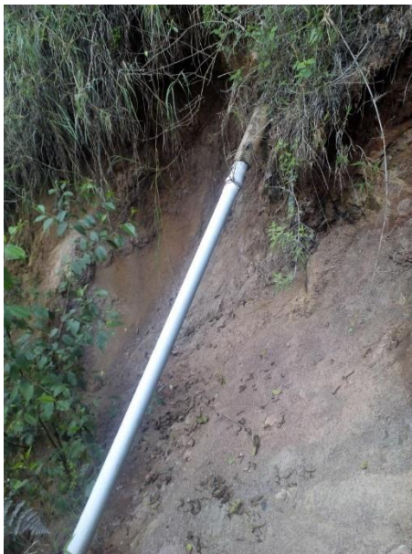
Figura 2-22. Tubería a nivel de terreno (Deslizamiento)
