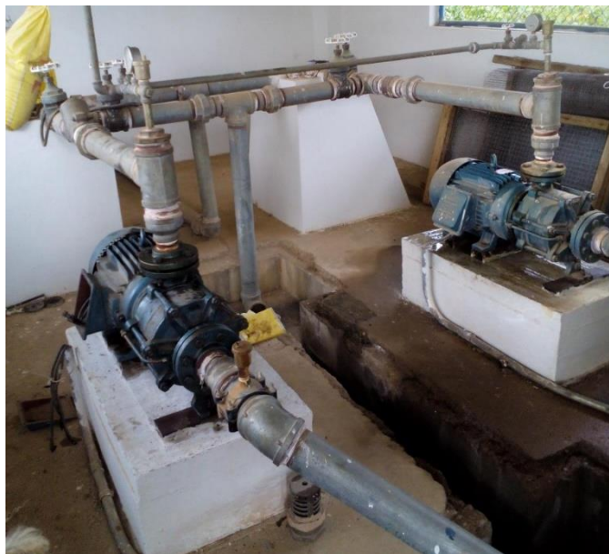
Figura 2-31. Sistema de bombeo (2 unidades)
